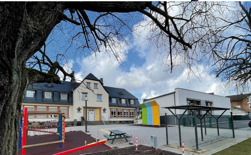
Im Jahr 2021 wurde der neue Anbau der Grundschule Jungeroth fertiggestellt und die Außenanlage erneuert.
